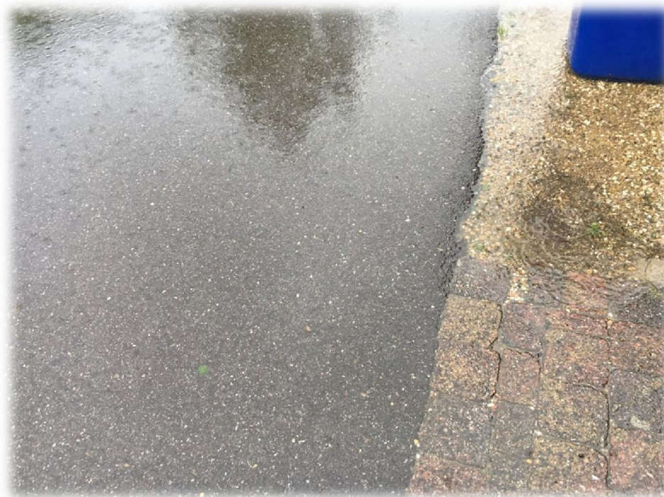
Goerree-Overflakkee: lichte plasvorming op straat.
